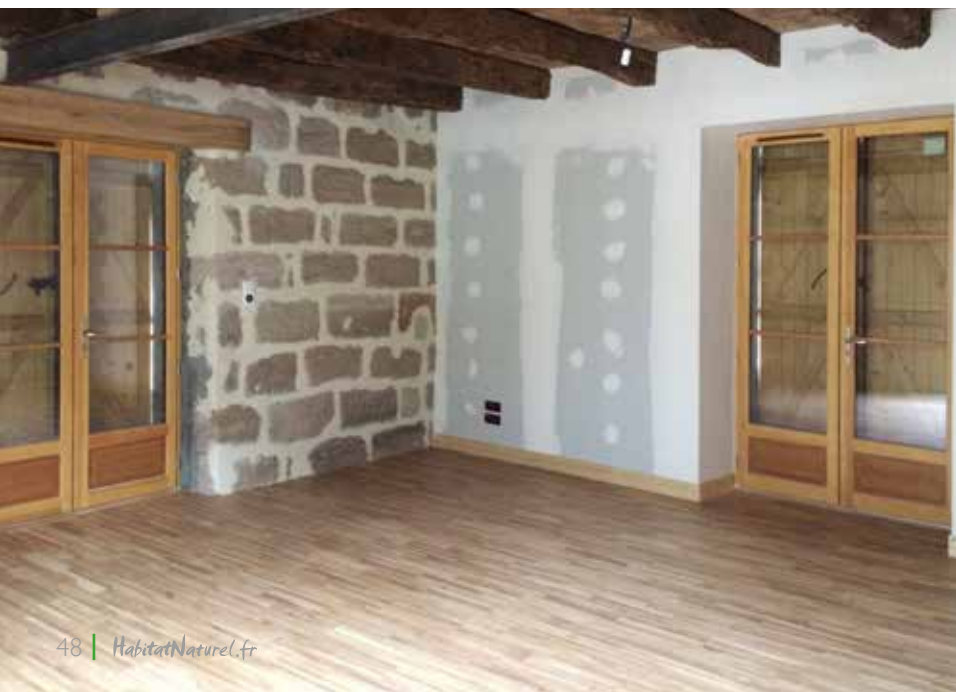
Isolation par l'intérieur par 145 mm de laine de bois, une isolation respectueuse de la perspiration des murs en pierre. Pose de plaques de Fermacell en finition ou murs en pierres apparentes rejointoyées. Au sol, un parquet chêne massif. Les menuiseries sont neuves.
