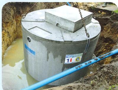
Gamme de stations SIMBIOSE sans électrovannes et sans coffret de commande, seul le surpresseur est à raccorder au tuyau d'alimentation en air.
